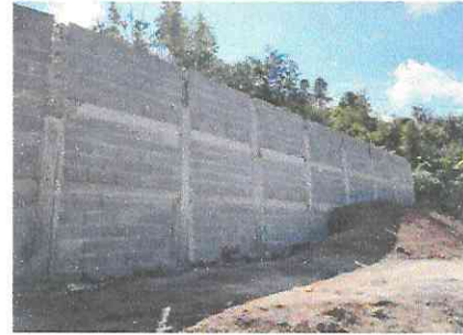
Foto 2: En esta otra parte del muro perimetral se puede observar como la pared llega al límite del terreno del establecimiento cerrando el perímetro del establecimiento en su totalidad.
