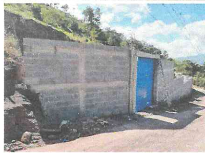
Foto 6: se evidencia que se sustituyo con muro block y se cerro en su totalidad el perímetro del establecimiento por la parte de enfrente.
